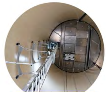
Blick in den Stahlrohrturm mit Leiter und Aufzug
