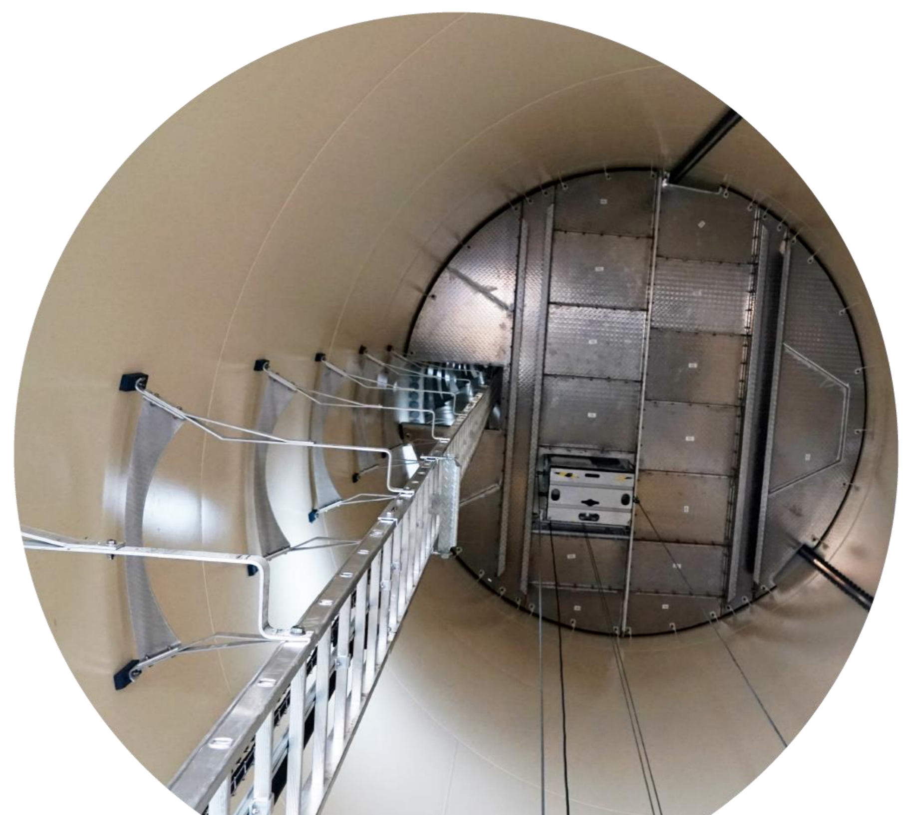
Blick in den Stahlrohrturm mit Leiter und Aufzug
