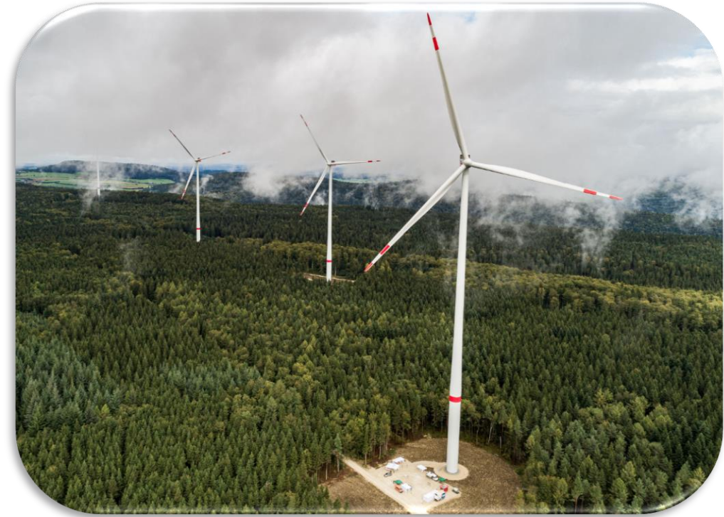
Windpark Junge Donau (21 MW), Ba.-Wü., Inbetriebnahme 2023
