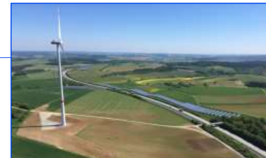
juwi-Windpark Lauda-Heckfeld 2xV126-3.45MW auf 137m NH. IB 2020 1 x V162-5.6MW auf 169m NH. IB 2024
