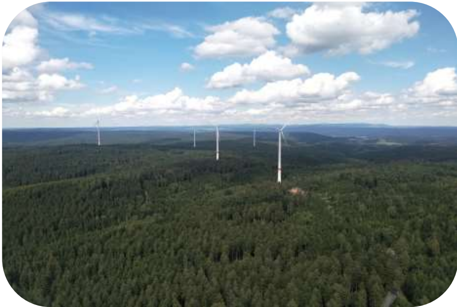
Windpark Roskopf (16,5 MW), Hessen, Inbetriebnahme 2020
